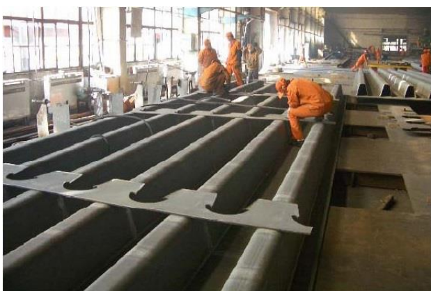
Manuell tillverkning av konventionell ortotrop platta, bild: [1].
